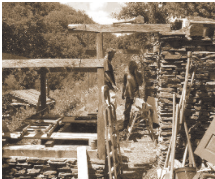
Pierres ramassées sur place + poutres de châtaignier coupées à la tronçonneuse + baie vitrée de récupération + mes mains et celles des copains = une cabane de 16m 2 solide et très économique. Coût : 200 euros (matériaux et outils)
